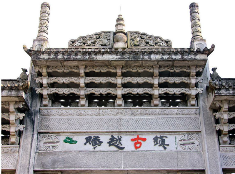
云南腾冲新牌楼局部（一）
