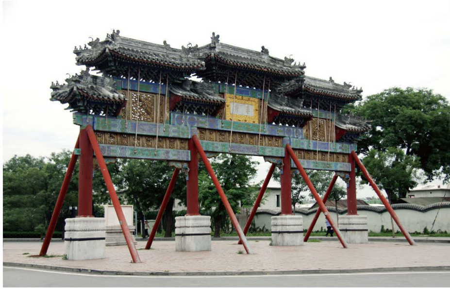
四柱三开间七楼牌楼
